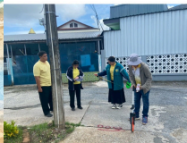
โครงการก่อสร้างถนนคอนกรีต เสริมเหล็กซอยสาทรณ์ครู
