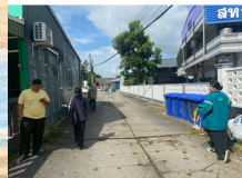
โครงการก่อสร้างถนนคอนกรีต เสริมเหล็กซอยสาทรณ์ครู
