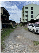
โครงการก่อสร้างถนนคอนกรีต เสริมเหล็กถนนเนินต้ามะขอย1
