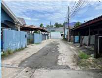
โครงการก่อสร้างถนนคอนกรีต เสริมเหล็กถนนเนินต้ามะขอย1
