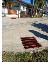
โครงการวางท่อระบายน้ำ บริเวณถนนราษฎร์อุทิศ
