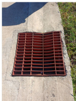
โครงการวางท่อระบายน้ำ บริเวณถนนราษฎร์อุทิศ
