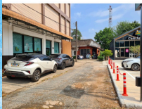
โครงการก่อสร้างถนนคอนกรีต เสริมเหล็กถนนเนินตาแมวซอย1
