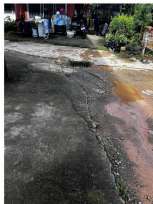
โครงการก่อสร้างถนนคอนกรีต เสริมเหล็กถนนเนินตาแมวซอย1
